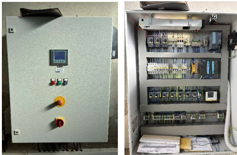
Abbildung 8: Steuerschrank Sandwäscher außen (links) und innen (rechts)
